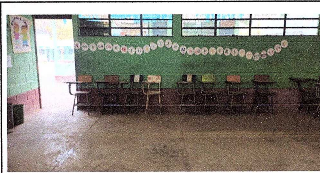
FOTO 2: Pintura general en muros exteriores e interiores
