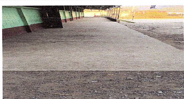
FOTO 3: SUSTITUCION DE PISO DE CNCRETO POR CERAMICA EN CORREDOR
