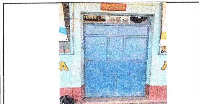
Foto 5: MODULO 1 sustitucion de las puertas de las aulas de metal.
