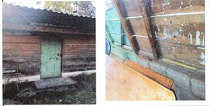
Foto 2: BODEGA: Sustitución de lámina por lámina troquelada aluzinc calibre 26
