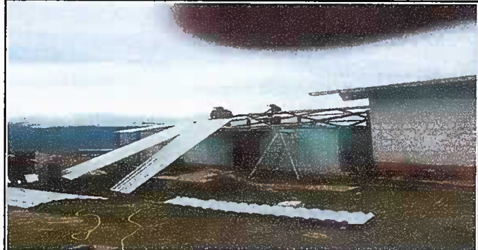
Foto 2: Modulo 1. Sustitución de laminas.
