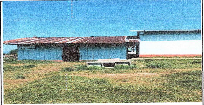
Foto 2: Modulo 1. Sustitución de laminas.
