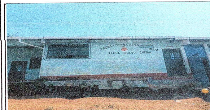
Foto 5: Modulo 5. reparación de banqueta de concreto.
