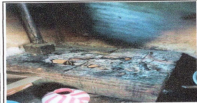
Foto 3: Modulo 1 mantenimiento de estufa de cocina
