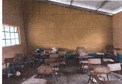
Foto 10 Modulo 2 Sustitucion de piso de torta de concreto por piso porcelanato
