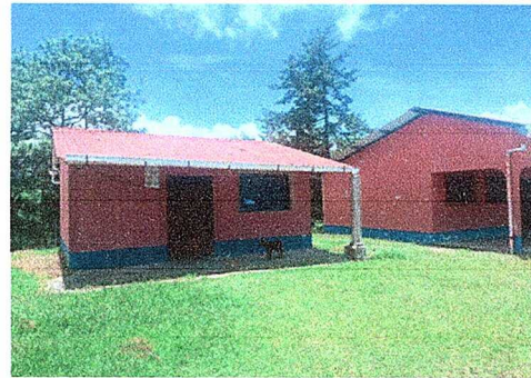
Foto 6 Modulo 1 Desinstalacion de lamina existente
