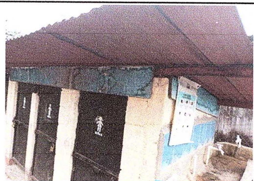
Foto 16 Modulo 3 sustitucion de estructura de soporte de madera, por metal
