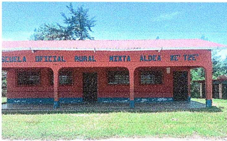
Foto 11 Modulo 2 Mantenimiento a estructuras de puertas, corte, lijado, sujecciones y aplicacion de pintura
