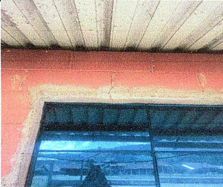
Foto 3 Modulo 1 sustitucion de canal de pvc
