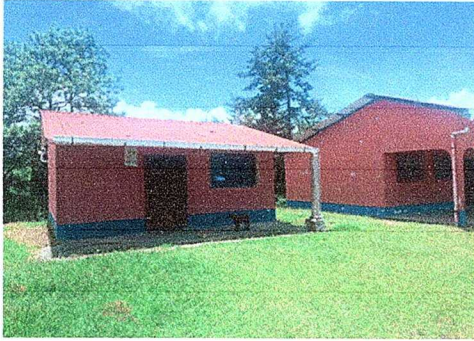
Foto 7 Modulo 1 Instalacion de lamina existente.
