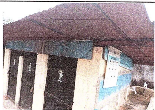
Foto 14 Modulo 3 Sustitucion de elementos de fijacion (tornillos)
