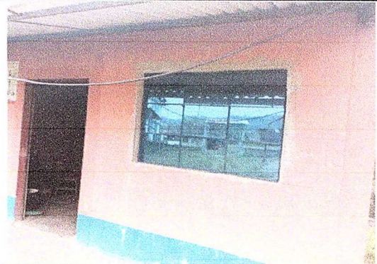
Foto 2 Modulo 1 Suministro e instalacion de balcon de hierro de ventana
