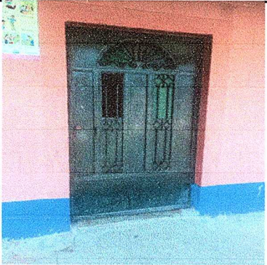
Foto 1 Modulo 1 Mantenimiento a estructura de puertas, corte, lijado, sujecciones, y aplicación de pintura.
