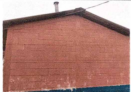
Foto 4 Modulo 1 Pintura en muros exteriores e interiores
