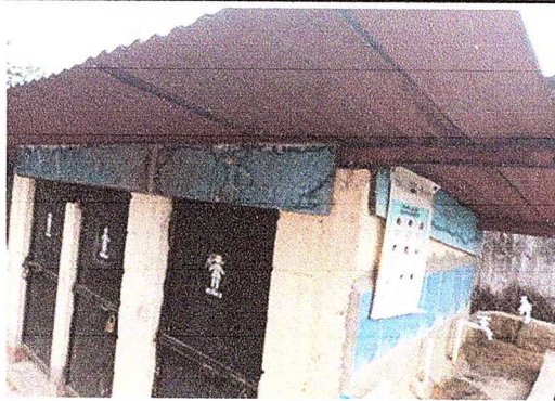
Foto 15 Modulo 3 Sustitucion de lamina, por lamina troquelada aluzinc calibre 26
