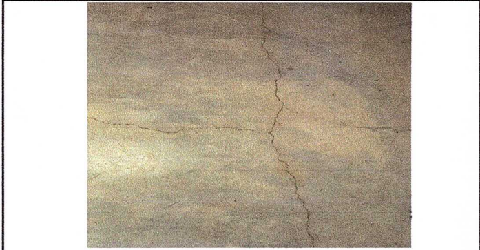
MODULO 1 SUSTITUCION DE PISO CERAMICO
