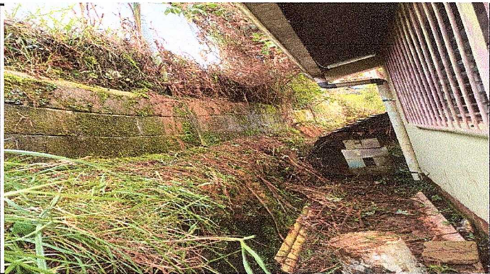
REPARACION DE MURO DE CONTENCIÓN
