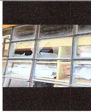
SUSTITUCION DE VIDRIOS
