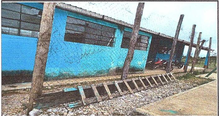
Foto 4: CANCHA Reparación de muro perimetral de block con tubo hg y malla galvanizada, soleras intermedias y columnas
