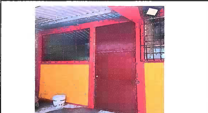
Foto 3: modulo 3: instalacion de ventanas y puerta para el aula
