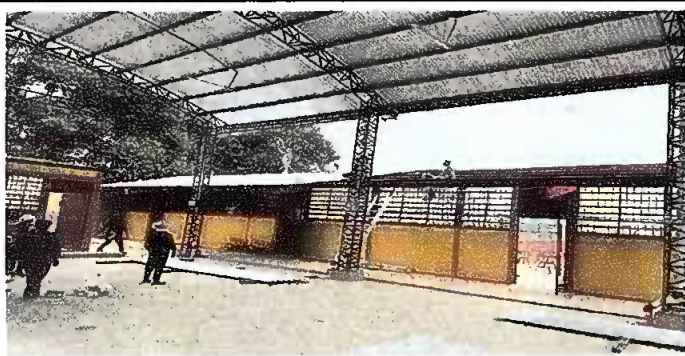
Foto 5: INSTALACION DE LAMINA
