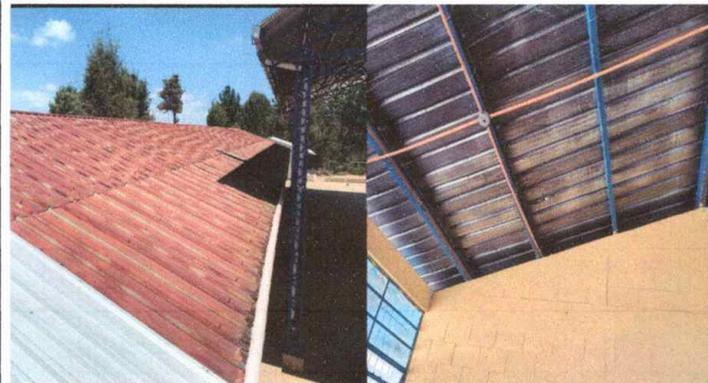
Foto1: Modulo 1: Sustitución de Lámina y Capote.
