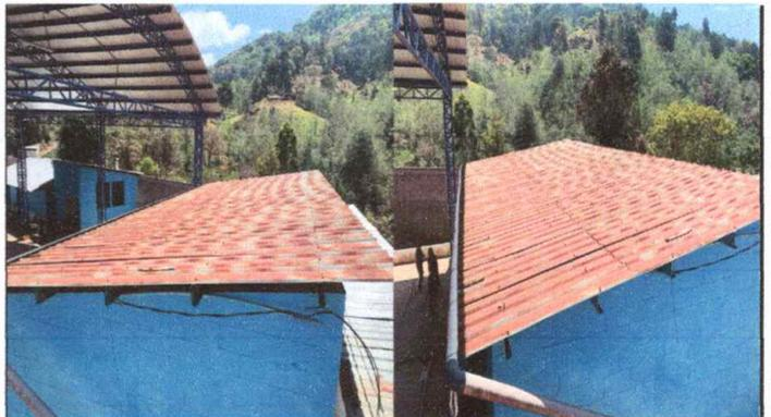
Foto 2: Modulo 2: Sustitución de lámina en mal estado y capote.
