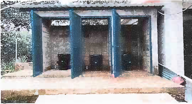
Foto 1: Colocación de sanitarios lavables
