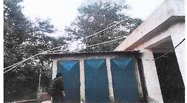
Foto 2: Colocación de puertas
