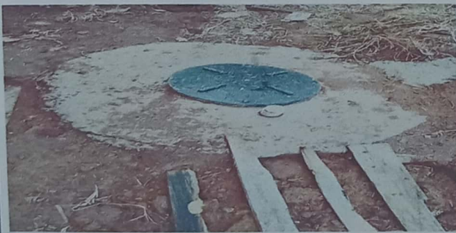
Foto 5: Instalación de biodigestor de 1300 litros
