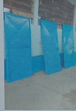
Foto 2: Cambio de puertas para los sanitarios
