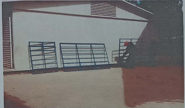
Foto 4: Sustitución de marcos metálicos para ventanas
