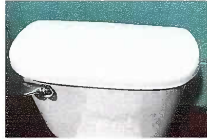
Módulo 3: Cambio de tapadera de sanitario
