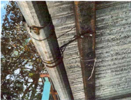
Módulo 2: Sustitución de soporte o pescante de metal para canal
