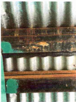
Módulo 2: Mantenimiento a estructura de soporte de metal
