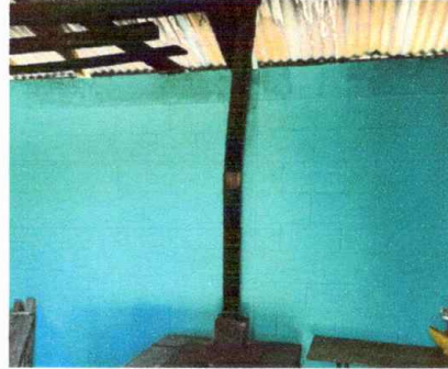
Módulo 2: Sustitución de chimenea de concreto
