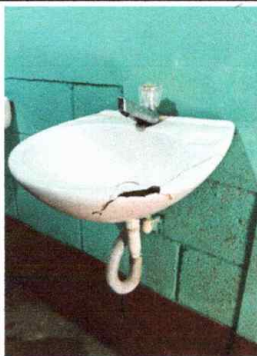
Módulo 3: Sustitución lavamanos
