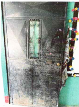
Módulo 1: Fabricación o instalación de puerta metal
