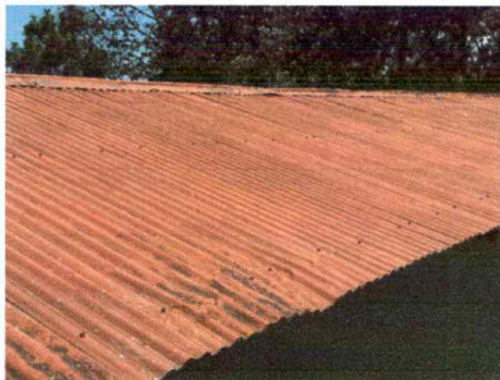
Módulo 1: Sustitución de lámina, por lámina troquelada aluzinc calibre 26
