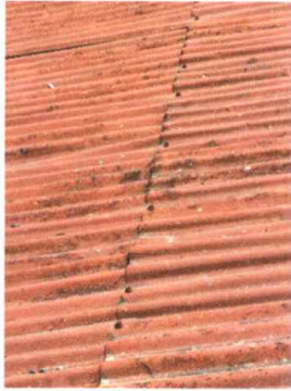
Módulo 2: Sustitución de elementos de fijación
