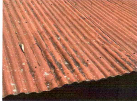
Módulo 1: Desinstalación de lámina existente
