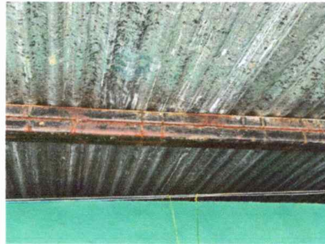
Módulo 1: Mantenimiento a estructura de soporte de metal
