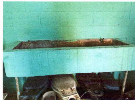
Módulo 2: Sustitución de lavatrastos (incluye mezcladora)
