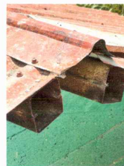
Módulo 2: Sustitución de capote de lámina para lámina troquelada
