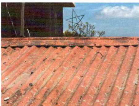
Módulo 1: Sustitución de capote de lámina para lámina troquelada
