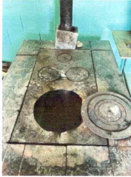
Módulo 2: Sustitución de plancha de metal de 3 hornillas
