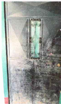
Módulo 2: Fabricación o instalación de puerta de metal
