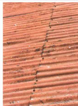
Módulo 1: Sustitución de elementos de fijación
