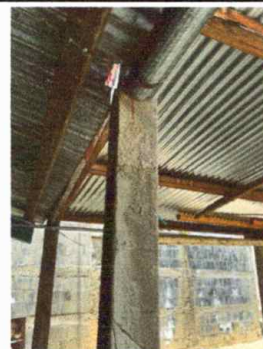
Módulo 1: Sustitución de bajada de agua pluvial de metal por PVC 3"
