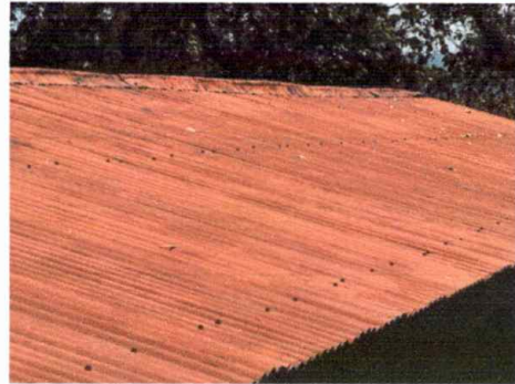
Módulo 2: Desinstalación de lámina existente
