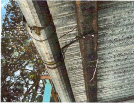
Módulo 1: Sustitución de soporte o pescante de metal para canal
