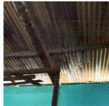
Módulo 2: Sustitución de lámina, por lámina troquelada aluzinc calibre 26
