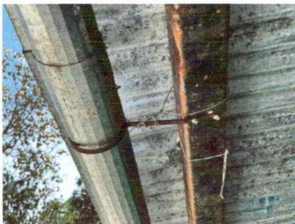
Módulo 1: Sustitución de canal de metal
