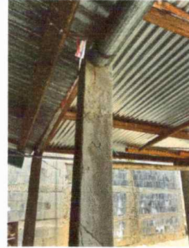
Módulo 2: Sustitución de bajada de agua pluvial de metal por tubo PVC 3"
