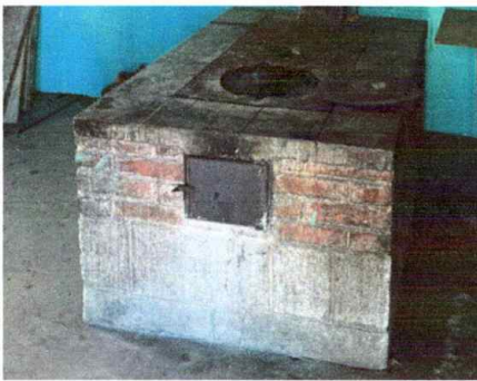
Módulo 2: Instalación de azulejo en estufa rural
