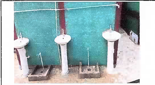
Foto7: Sustitución de lavamanos.
