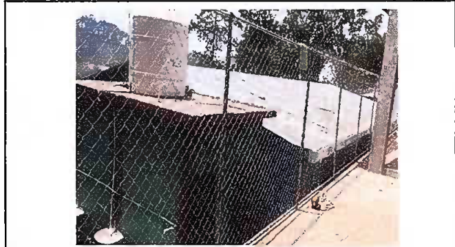
Foto 8: Reparación de tubo hg y malla galvanizada.
