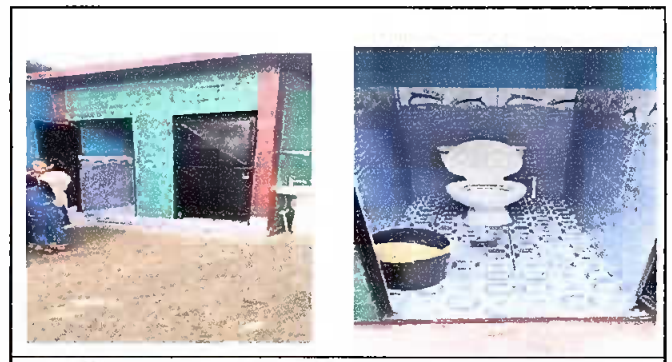
Foto 6: Mantenimiento a reposadera, Sustitución accesorios inodoro (contra llave, tubo de abasto.) y Sustitución de piso cerámico.
