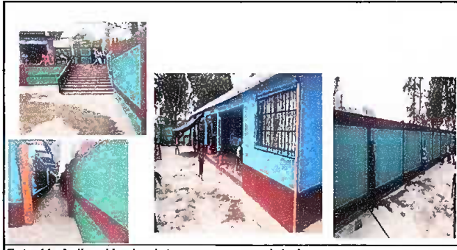
Foto 11: Aplicación de pinturas con muros interiores.
