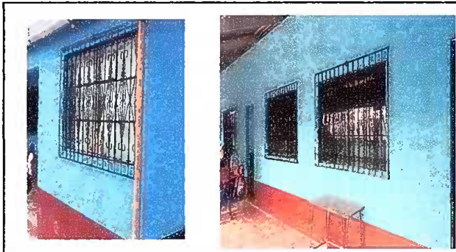
Foto 3: Mantenimiento a balcones de metal.
