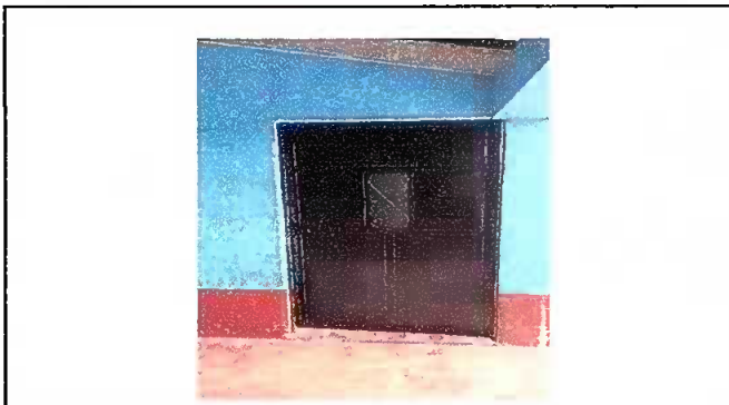
Foto 1: Fabricación e instalación de puertas de metal
