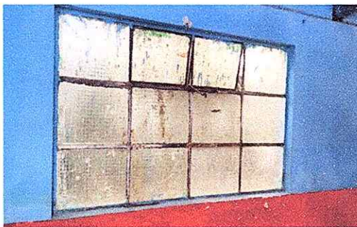
Foto 5: Sustitución de vidrios
