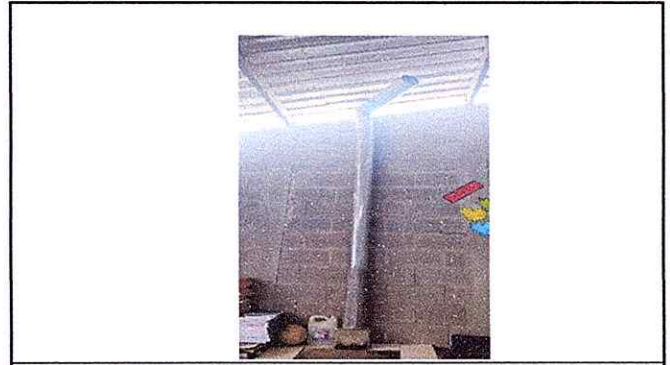
Foto 8: Sustrucción de Chimenea.
