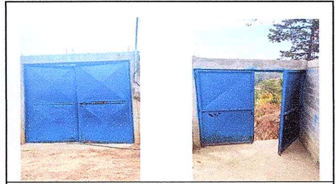
Foto 10: Mantenimiento de portones (lijado y aplicación de pintura.)
