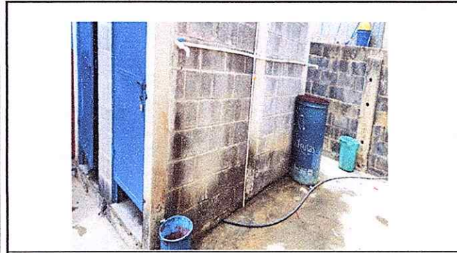
Foto 7: Sustrucción de lavamanos.
