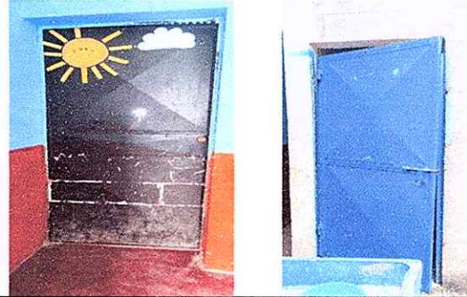
Foto 2: Mantenimiento de puertas de metal (lijado, aplicación de pintura.)
