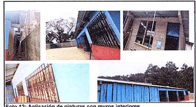
Foto 12: Aplicación de pinturas con muros interiores.
