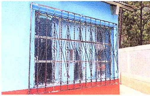
Foto 3: Mantenimiento a balcones de metal.
