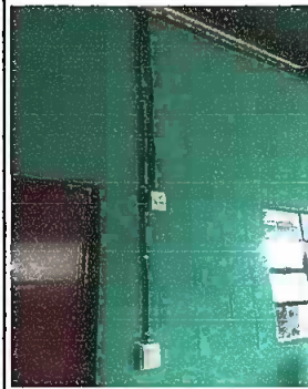
Foto 4: Sustitución de cableado eléctrico y sustitución de ducto eléctrico más accesorios.
