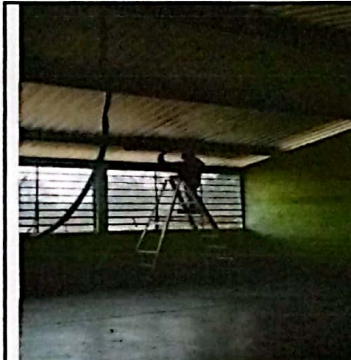
Foto 4: Sustitución de cableado eléctrico y sustitución de ducto eléctrico más accesorios.
