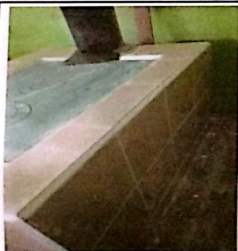
Foto 5: Sustitución de plancha de 3 hornillas, instalación de azulejo en estufa rural.
