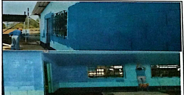
Foto 6: Pintura en muros interiores y exteriores.
