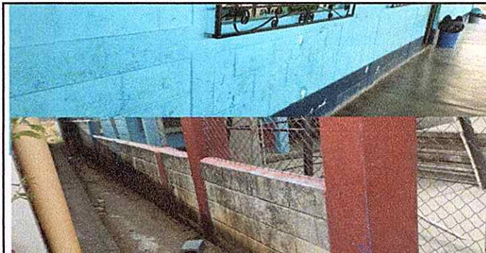
Foto 6: Pintura en muros interiores y exteriores.
