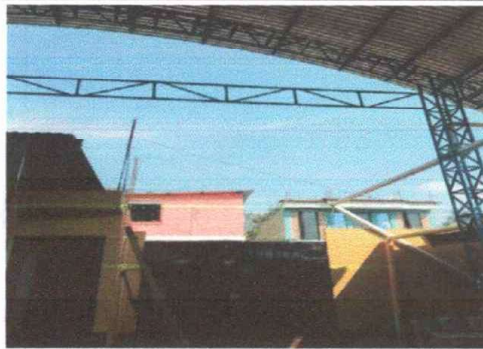
Foto 3: Modulo 3 Instalacion de lamina troquelada aluzinc
