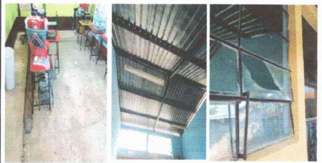
Foto 2: Modulo 2 Sustitucion de piso de torta de concreto
