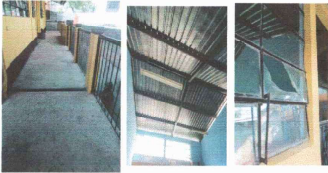
Foto1: Modulo 1 Sustitucion de piso de torta de concreto
