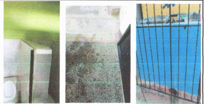
Foto 4: Modulo 4 cambio de azulejo
