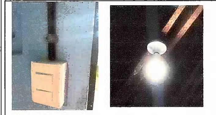
Foto1: Módulo 1: Sustitución de focos, sustitución de apagadores, sustitución de toma corrientes, repacación de cables eléctricos.
