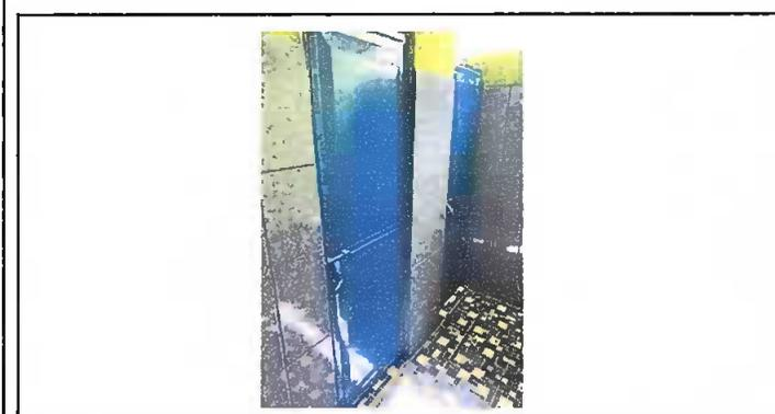
Foto 5: Módulo 5 reparación de puertas, sustitución de inodoros, sustitución de accesorios de inodoro, sustitución de piso y azulejo.
