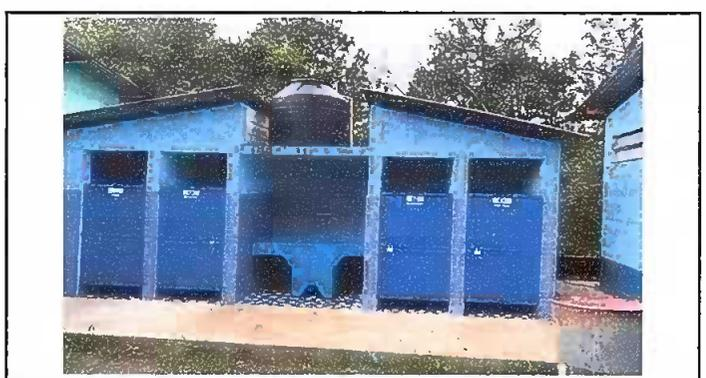
Foto 6: Módulo 5: reparación de depósto de agua, instalación de pila.
