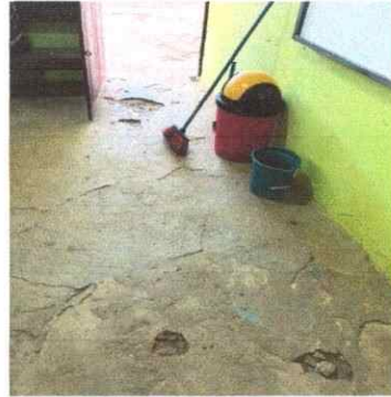
Foto 2: Sustitucion de torta de cemento.
