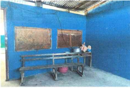
Foto7: Sustitución de ventanas de madera de la cocina.
