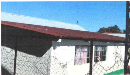
Foto 5: Sustitución completo de lamina simple a lámina troquelada de 2 aulas.
