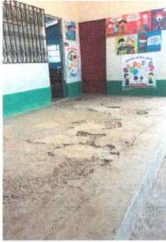
Foto1: Sustitución de torta de cemento por un nuevo.
