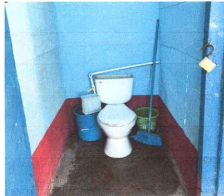
Foto 4: Sustitución de inodoros
