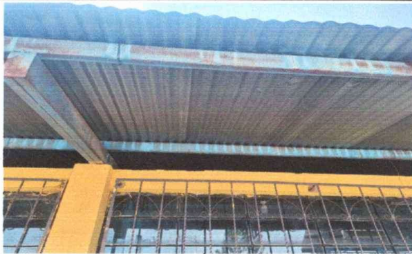
Módulo 1: Mantenimiento de Estructura
