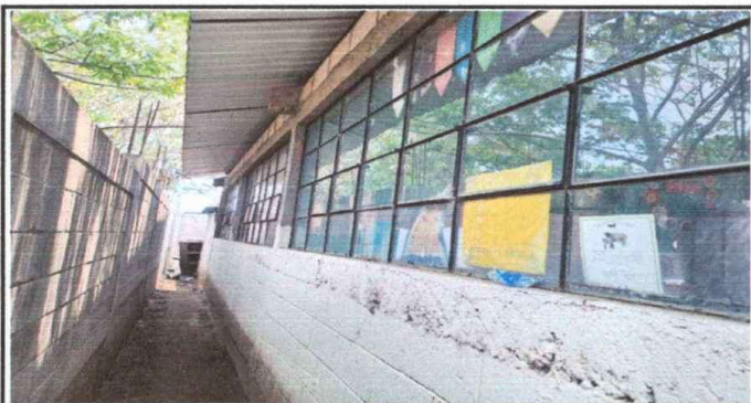
Modulo 4: Suministro de Balcones a 2 aulas
