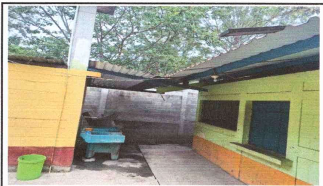
Modulo 3: Sustitución de pila y sustitución de lamina en galera
