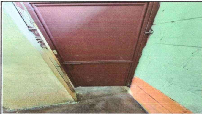
Módulo 2: Cambio de puertas en los baños.
