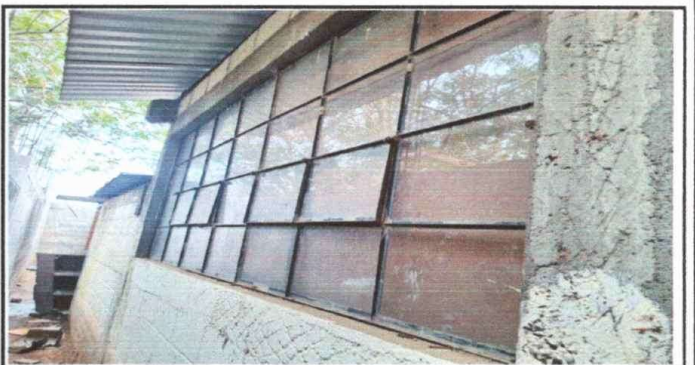
Modulo 4: Suministro de valcones a 2 aulas
