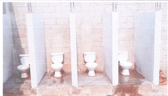
Foto 6: Sustitución de puertas de baños en módulo 4
