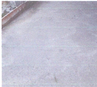
Foto 3: Sustitución de piso cerámico en módulo 2
