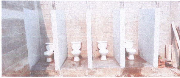
Foto7: Sustitución de tazas para servicios sanitarios en módulo 4
