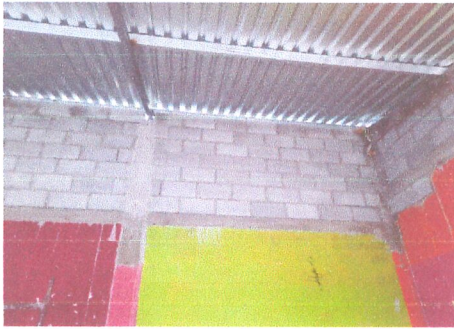
Foto 9: pintura en muros exteriores e interiores en módulo 5
