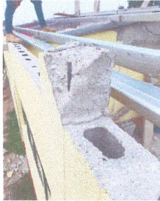
Foto1: Sustitucion de lamina y estructura portante en el módulo 1
