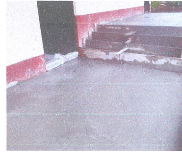
Foto 2: Sustitución de piso de concreto en el módulo 1
