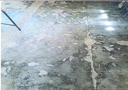
Foto 3: Sustrucción de piso cerámico en módulo 2
