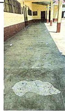
Foto 4: Sustrucción de piso de concreto en modulo 3
