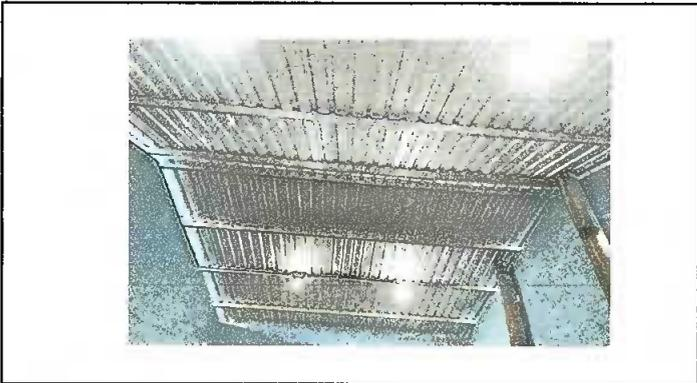
Módulo 1: Sustitución de lámina por lámina troquelada aluzinc calibre 26, sustitución de estructura de soporte de metal por metal y sustitución de capote lámina troquelada.
