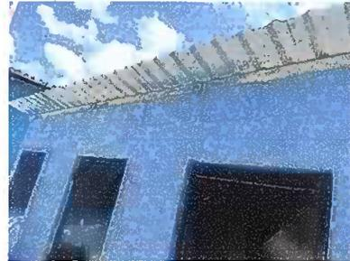
Módulo 4. Sustitución de estructura de soporte de madera por metal.
