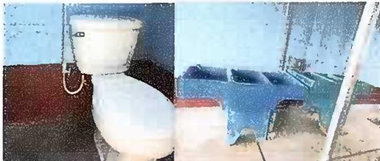
Modulo 4. Sustitución de accesorios inodoros y sustitución de pila de cemento de dos lavaderos.
