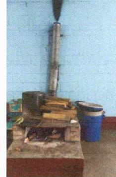
Módulo 1: Mantenimiento a estufa rural, sustitución de plancha de metal, suministro e instalación de azulejo en estufa rural, y sustitución de chimenea de concreto.
