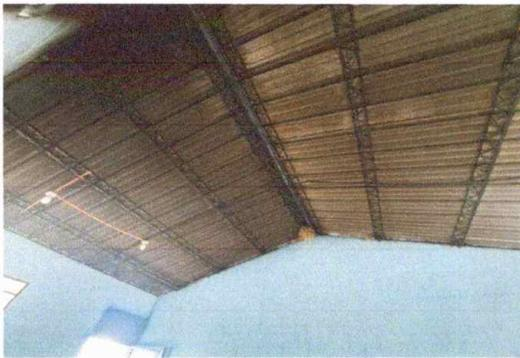
Módulo 1: Sustitución de lámina por lámina troquelada aluzinc calibre 26, sustitución de estructura de soporte de metal por metal y sustitución de capote lámina troquelada.
