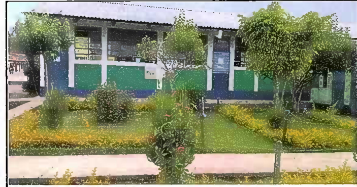
FOTO NO. 6 Pintura de muros exteriores
