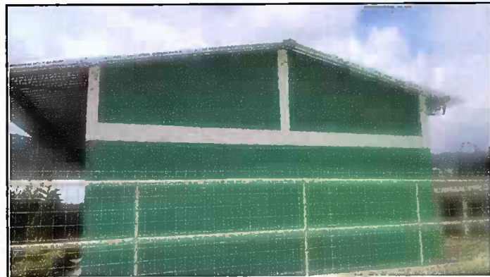
FOTO NO. 3 Módulo 1: levantado de mojinete
