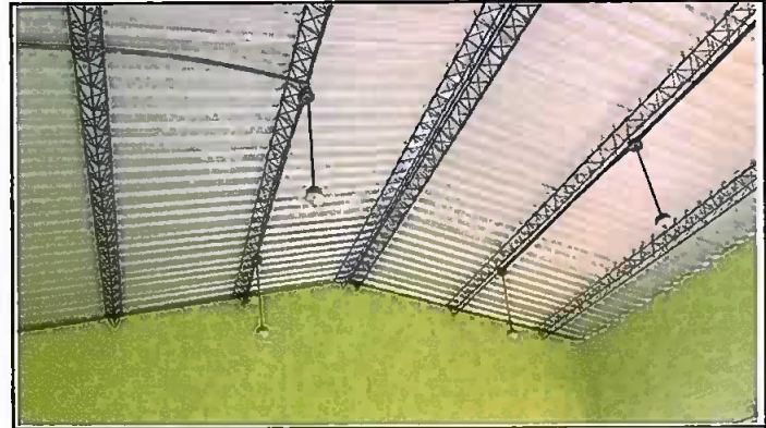
FOTO NO. 4 Modulo 1: Reparación de cableado eléctrico
