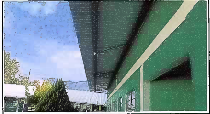
FOTO NO. 2 Módulo 1: Mantenimiento de estructura portante de metal
