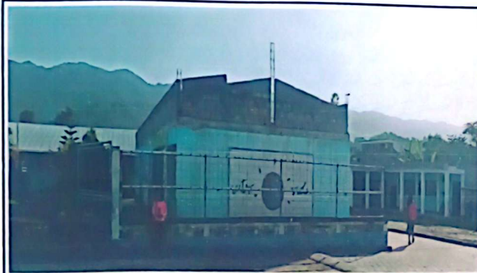
FOTO NO. 3 Módulo 1: levantado de mojinete
