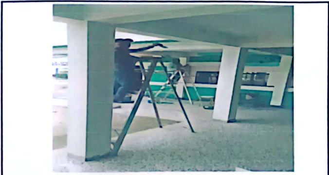
FOTO NO. 6 Pintura en muros exteriores.
