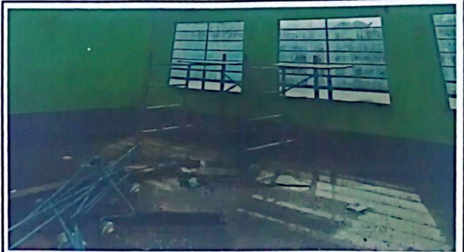
FOTO NO. 4 Modulo 1: Reparación de cableado electrico
