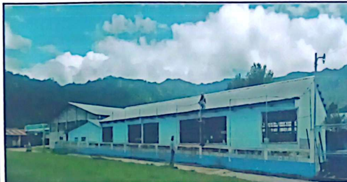
FOTO NO. 5 MURO PERIMETRAL: Reparación de muro perimetral con tubo hg y electromalla
