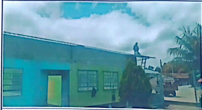
FOTO NO. 1 Módulo 1: Sustitución de lámina por lámina de aluzinc calibre 26
