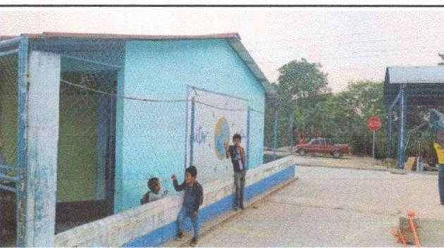
FOTO NO. 6 MURO PERIMETRAL: Reparación de muro perimetral con tubo hg y electromalla
