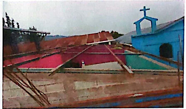
Foto 2: empiezan a limpiar el para luego pintar la estructura
