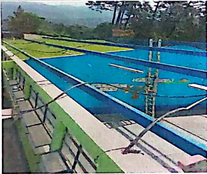
Foto 3: estan limpiando para restaurar el material
