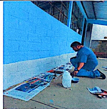
Foto 4: Modulo 1, pintura de muros de exteriores e interiores.
