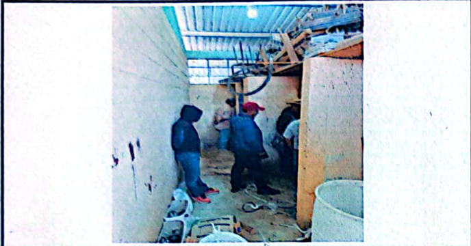
Foto 1: Modulo 2, sustitucion de Grifos.
