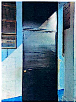
Foto 3: Modulo 1, sustitucion de chapa.
