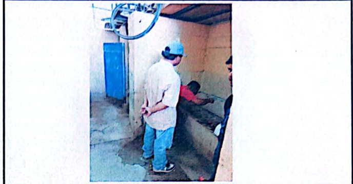
Foto 2: Modulo 2, sustitución de llave para mingitorios.
