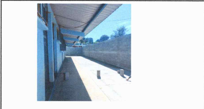
Foto 3: Modulo 2, Pintura en muros exteriores e interiores.
