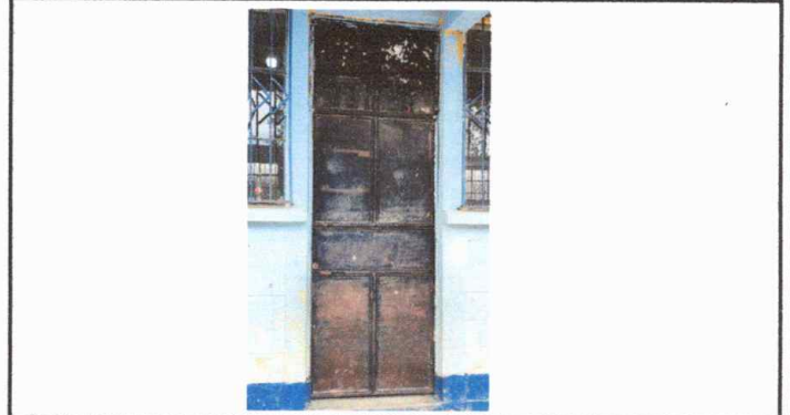
Foto 2: Modulo 2, Sustitucion de Chapa
