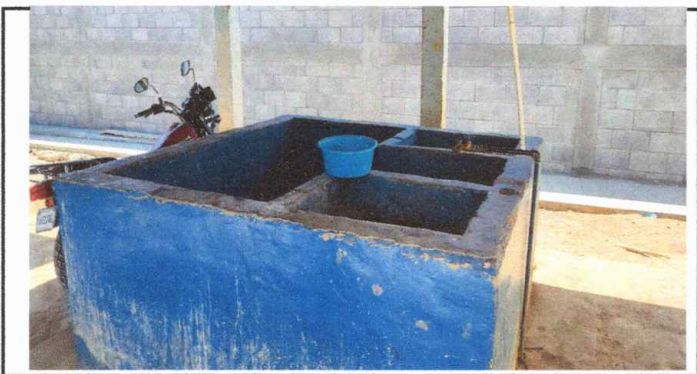
Foto 5: Modulo 4, Sutiitucion de pila de cemento de dos lavaderos.
