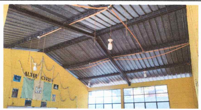
Foto 2: Modulo 1, sustitución de lamparas tipo LED.
