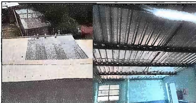
Foto 12: Sustitución de lámina, por lámina troquelada aluzinc calibre 26
