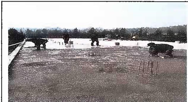
Foto 7: Impermeabilización de losa con full crete
