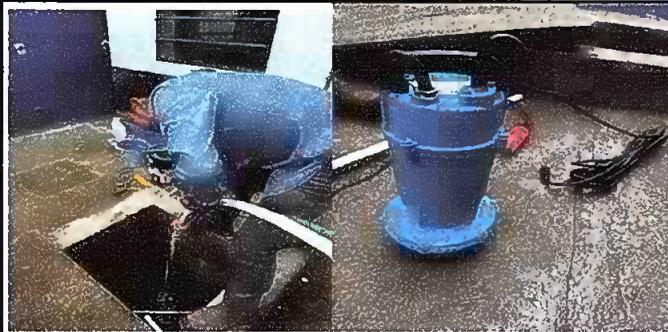
Foto 3: Sustitución de bomba de agua
