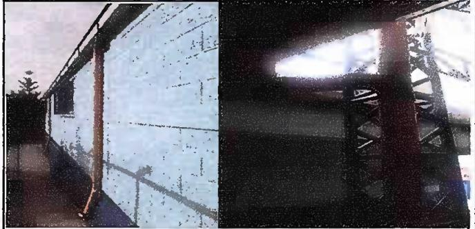
Foto 2: Reparación de bajada de agua pluvial, tubo PVC 4"
