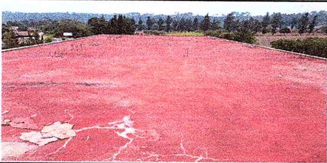
Foto 7: Impermeabilización de losa
