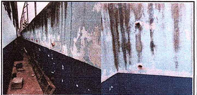
Foto 10: Pintura en muros exteriores e interiores
