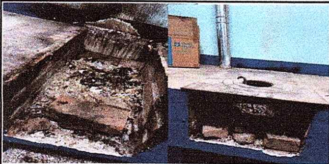
Foto 9: Sustitución de estufa rural (completa) incluye chimenea y plancha de metal
