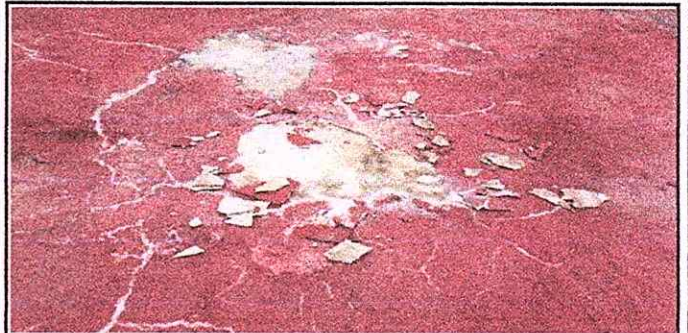
Foto 8: Reparación de pañuelos
