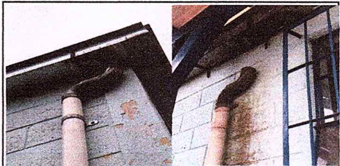
Foto 2: Reparación de bajada de agua pluvial, tubo PVC 3"
