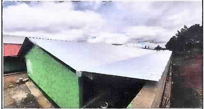
Foto 2: Sustitución de lámina a lámina troquelada y capote con caídas de agua y canales de VPC a 2 aulas, 1 dirección y 1 bodega.
