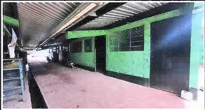
Foto 3: Sustitución de cunetas para aguas pluviales y sustitución de 6 chapas.
