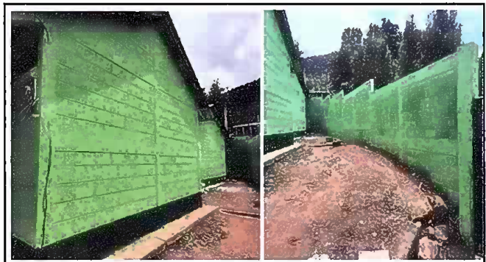
Foto 7: Aplicación de pintura a muros de interiores y exteriores.
