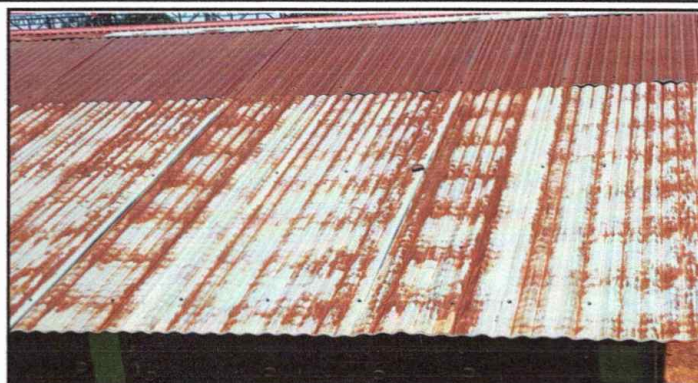
Foto 2: Sustitución de lámina a lámina troquelada y capote con caídas de agua y canales de VPC
