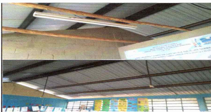
Sustitución y mejoramiento de la red eléctrica en 4 aulas, direcciones y patios.
