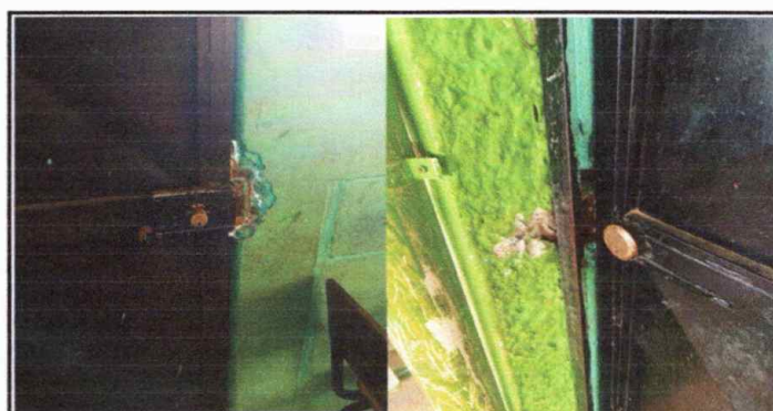
Sustitución 6 chapas y pintado de 8 puertas.
