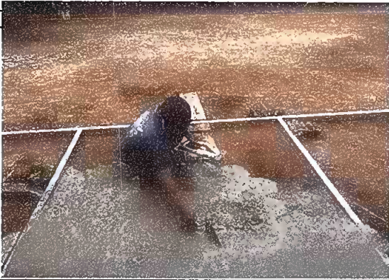
Foto 3: Patio, Reparación de planchas de concreto de patio
