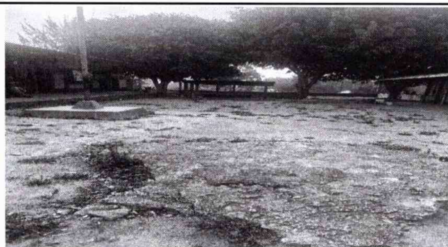
Foto 5: Patio, Reparación de planchas de concreto de patio
