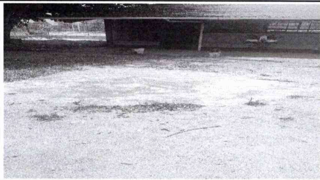
Foto 1: Patio, Reparación de planchas de concreto de patio
