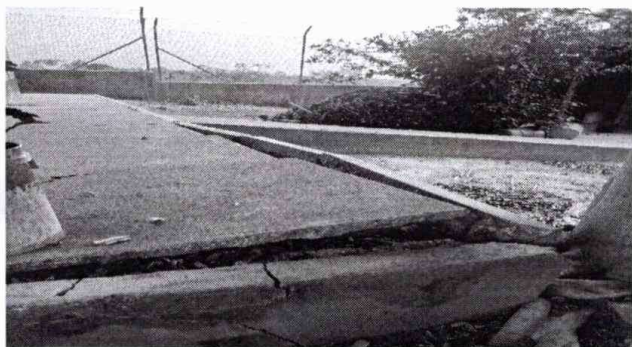
Foto 3: Patio, Reparación de planchas de concreto de patio
