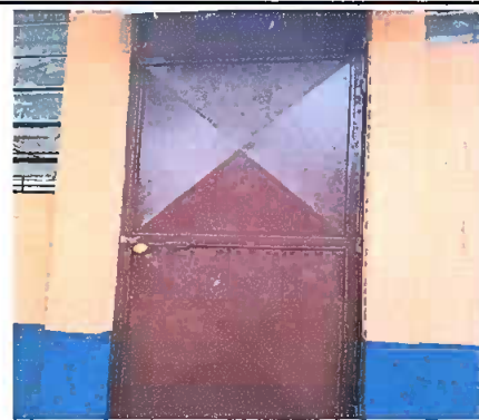
Foto 4. MODULO 2: Sustitución de chapa Yale para puerta
