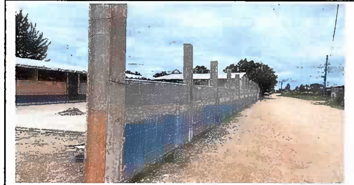
Foto 7. MURO PERIMETRAL: Reparación de muro perimetral frente a la escuela de block con soleras y columnas intermedias
