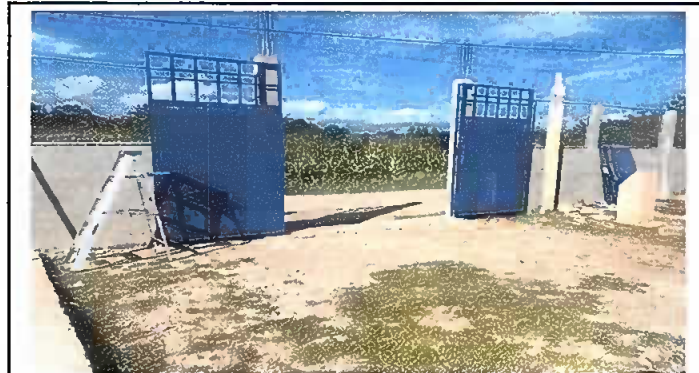
Foto 9. MURO PERIMETRAL: Sustitución de portón de metal de ingreso de malla por metal.
