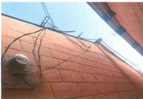
Foto 5. MODULO 2: Reparación de cabel eléctrico
