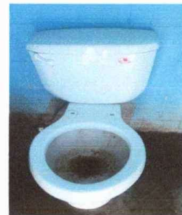
Foto 6. MODULO 3: Sustitución e instalacion de Inodoro
