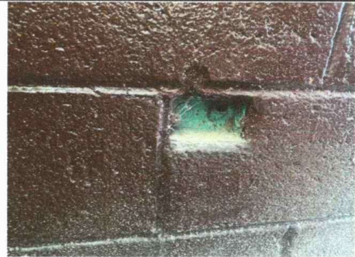
Foto 4. MODULO 2: Reparación de tamacorrientes dobles
