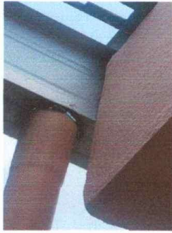
Foto 1 : MODULO 1: Reparación de bajada de agua pluvial
