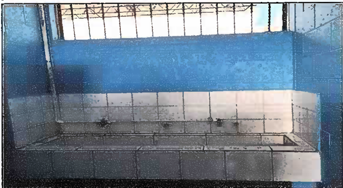
Módulo 3: Sustitución de azulejo
