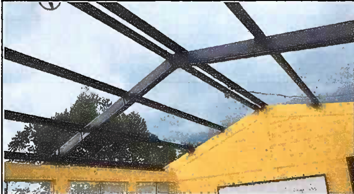
Módulo 1: Sustitución de lámina, por lámina troquelada aluzinc calibre 26
