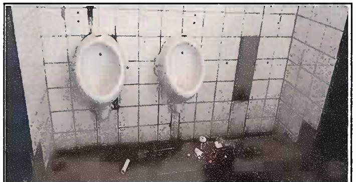
Módulo 3: Sustitución de mingitorio
