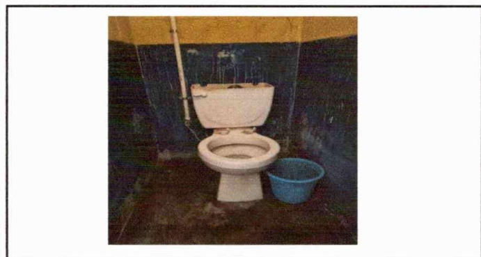
Módulo 3: Sustitución inodoro
