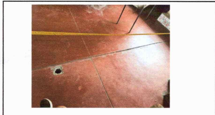
Módulo 2: Sustitución de piso por cerámico
