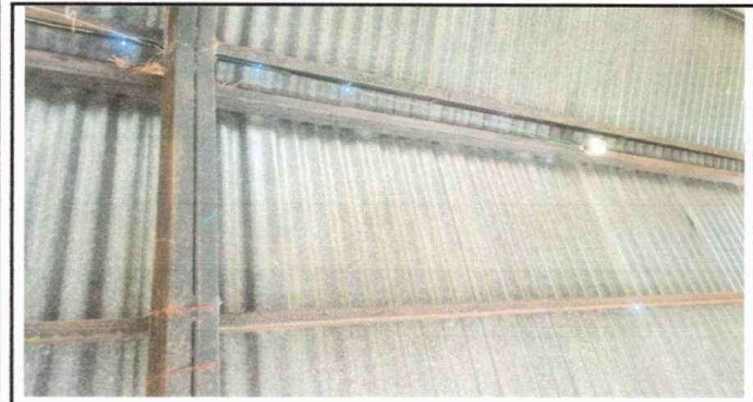
Módulo 1: Sustitución de lámina, por lámina troquelada aluzinc calibre 26
