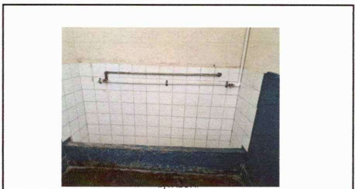
Módulo 3: Sustitución de mingitorio
