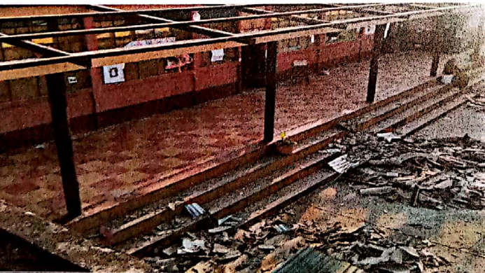
Foto 5: cambio de Lámina duralita por lámina Troquelada.
