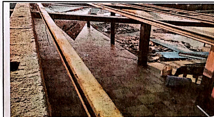
Foto 6: cambio de Lámina duralita por lámina Troquelada.
