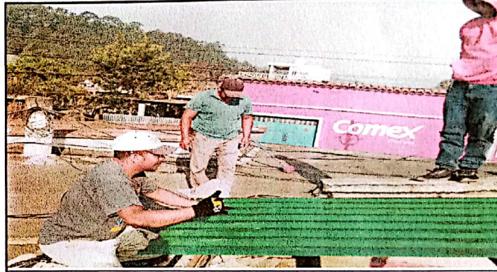
Foto 4: cambio de Lámina duralita por lámina Troquelada.
