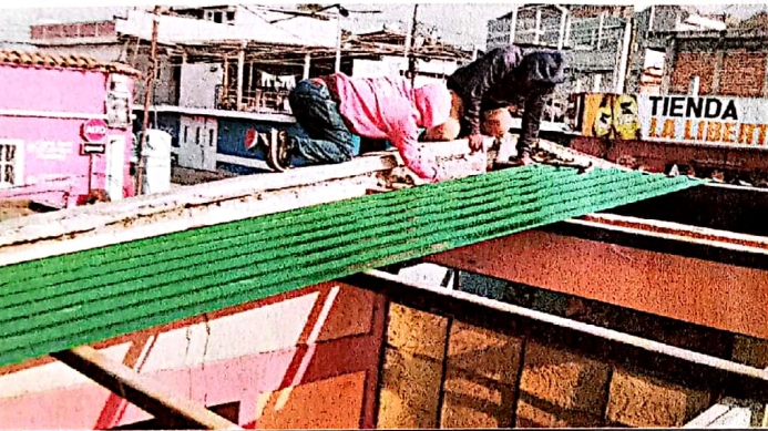
Foto 3: cambio de Lámina duralita por lámina Troquelada.
