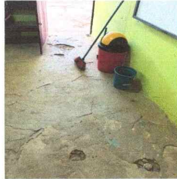
Foto 2: Sustitucion de torta de cemento.
