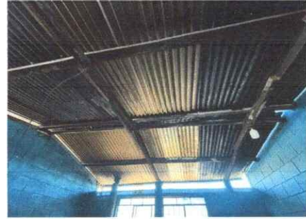
Foto 8: Sustitución del techado en general de la cocina.
