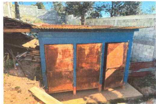
Foto 6: Sustitución de puertas de metal.
