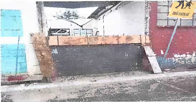
Foto 9: MURO PERIMETRAL, REPARACION DE MURO PERIMETRAL DE BLOCK.
