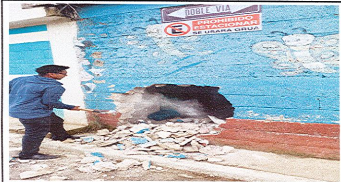
Foto 9: MURO PERIMETRAL, REPARACION DE MURO PERIMETRAL DE BLOCK.
