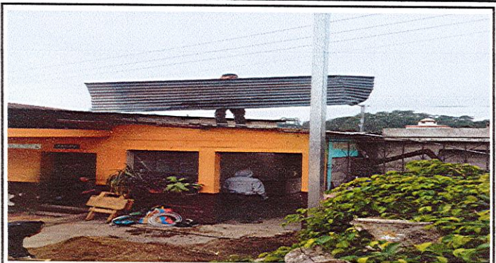
Foto 2: ESTRUCTURA DE TECHO. SUSTITUCION DE ESTRUCTURA DE SOPORTE DE METAL.
