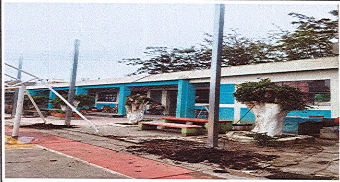
Foto 7: SUSTITUCIÓN DE PISO CERAMICO.
