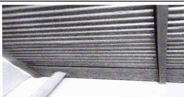
Foto 5: SUSTITUCIÓN DE LÁMINA, POR LÁMINA TROQUELADA ALUZINC C-26.
