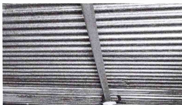
Foto 6: SUSTITUCIÓN DE ESTRUCTURA SOPORTE DE METAL, POR METAL.
